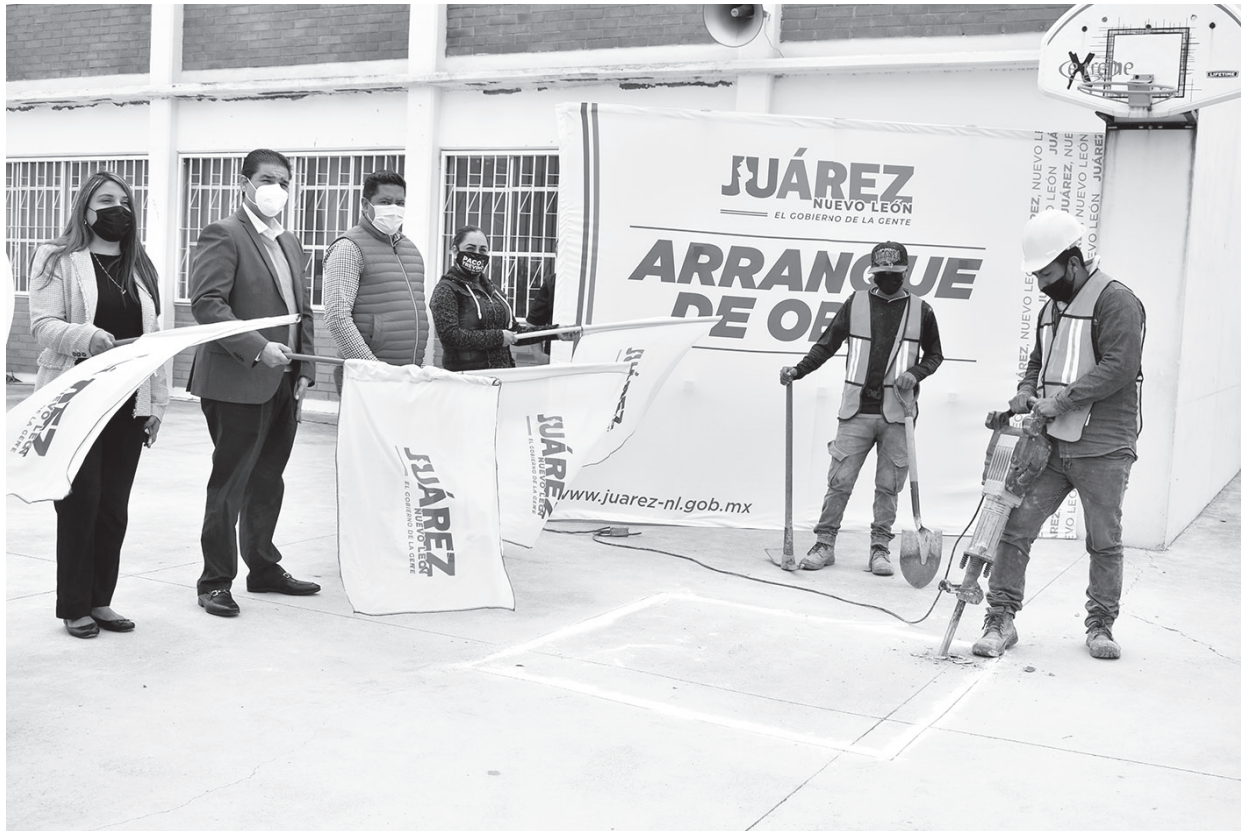
El alcalde Francisco Treviño dio el banderazo inicial con que arrancan los trabajos.
