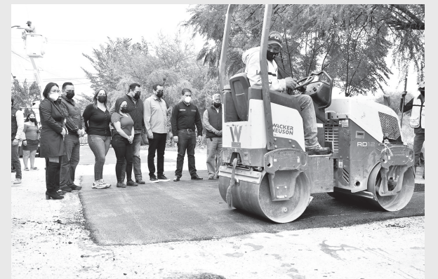
Paco Treviño supervisa los trabajos.
